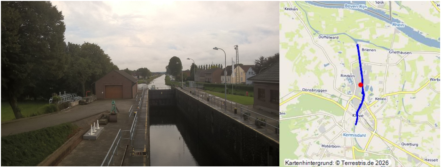
Spoynkanal mit der Schleuse vor der Mündung in den Griethauser Altrhein bei Kleve (2015) Fotograf/Urheber: Peter Burggraaf
