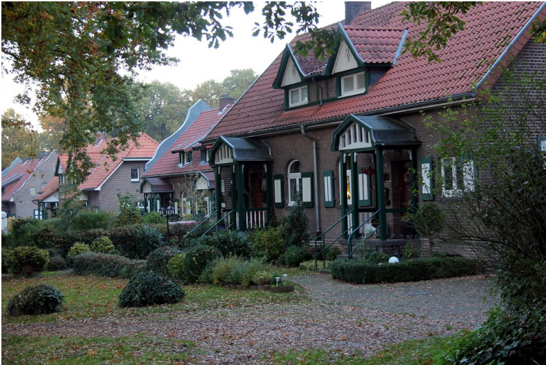
Wohngebäude mit kleinen Vorgärten im Gartenstadt-Stil in der LVR-Klinik Bedburg-Hau (2015) Fotograf/Urheber: Peter Burggraaf
