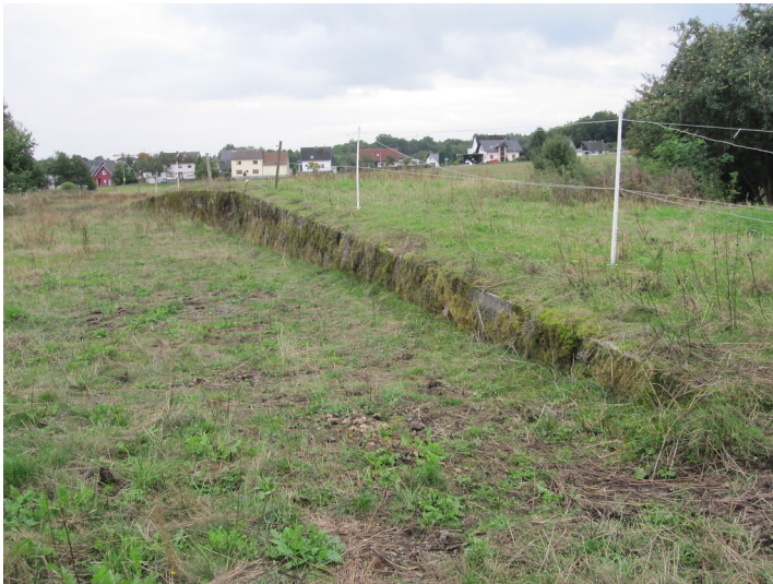
Mauerreste am ehemaligen Standort des Bahnhofs von Elbingen im Westerwald (2013) Fotograf/Urheber: Kölgen, Tobias
