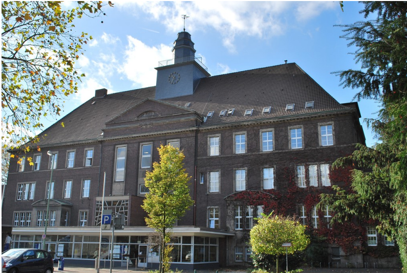
Bezirksrathaus Rheinhausen in Duisburg (2013). Der Haupteingang des Bezirksrathauses Rheinhausen ist die Rückseite der ehemaligen Schule. Fotograf/Urheber: Gelhar, Martina
