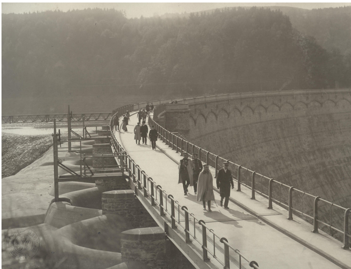
Besichtigung der Urfttalsperre durch Kaiser Wilhelm II (1906) Fotograf/Urheber: unbekannt
