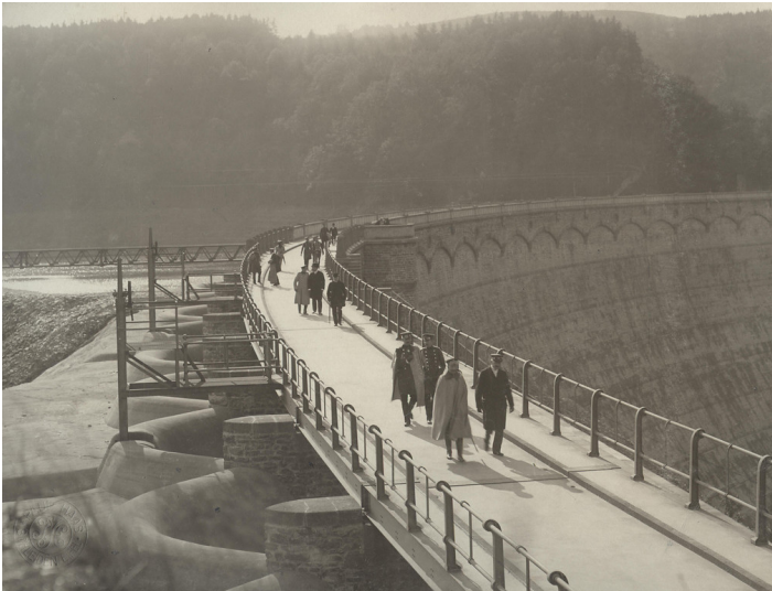
Besichtigung der Urfttalsperre durch Kaiser Wilhelm II Fotograf/Urheber: unbekannt
