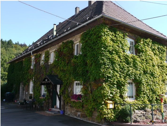
Der noch erhaltene Gebäudeteil der Börnhausener Burg bei Wiehl mit Fassadengrün (2013). Fotograf/Urheber: Schäfer, Wolfgang
