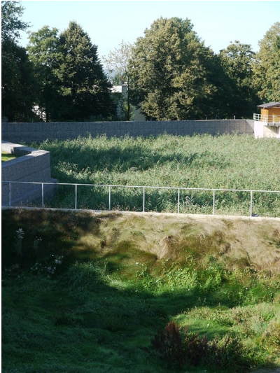
Retentionsbodenfilterbecken in Waldbröl (2013) Fotograf/Urheber: Schäfer, Wolfgang
