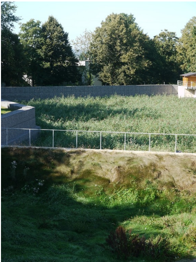
Retentionsbodenfilterbecken in Waldbröl (2013) Fotograf/Urheber: Schäfer, Wolfgang
