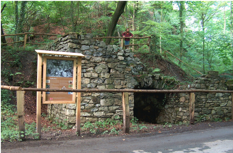
Gesamtansicht des Kalkofens Huppertsbracken in Haan-Gruiten (2007) Fotograf/Urheber: Eggerath, Hanna
