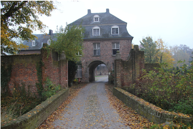
Torhaus des ehemaligen Klosters Graefenthal in Goch (2012) Fotograf/Urheber: Burggraaff, Peter
