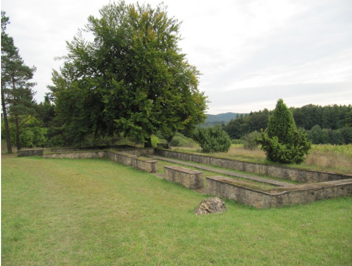
Die Mauern, welche die Umrisse des früheren römischen Heiligtums "Judenkirchhof" bei Gerolstein bilden (2013) Fotograf/Urheber: Keul, Benjamin
