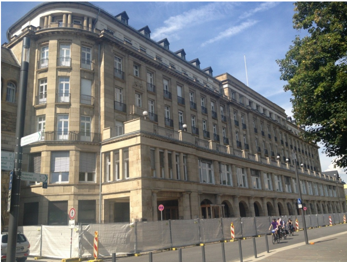
Der Koblenzer Hof, infolge der Sanierung von Bauzäunen umgeben (2013) Fotograf/Urheber: Bauer, Tobias
