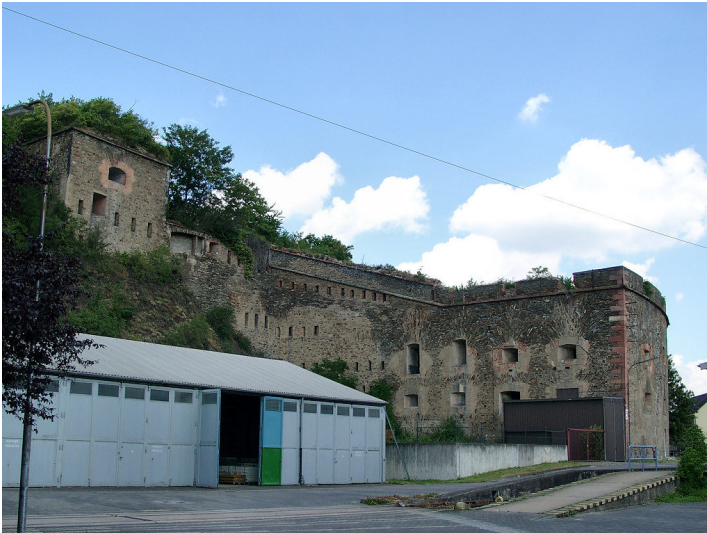
Die Preußische Festung "Feste Kaiser Franz" in Koblenz-Lützel (2004). Zu sehen sind der südliche Kopfbau des Hauptreduits (links) und der Kehlurm (rechts). Fotograf/Urheber: Holger Weinandt
