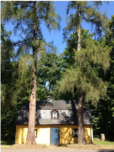
Das Jägerhäuschen im Kottenforst im Sommer 2013 Fotograf/Urheber: Schnadt, Jan Peter
