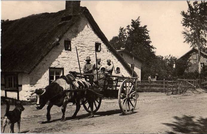
Reichsstraße 399 in der Ortslage Kalterherberg um 1900.
