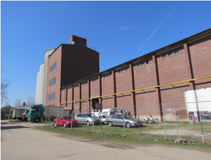
Die Gebäude der ehemaligen Sackabfüllung der Zuckerfabrik. Fotograf/Urheber: Harzheim, Gabriele
