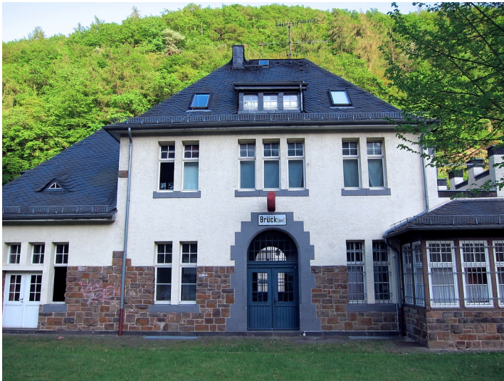
Bahnhofsgebäude in Ahrbrück (2015) Fotograf/Urheber: Elmar Knieps
