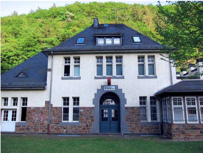
Bahnhofsgebäude in Ahrbrück (2015) Fotograf/Urheber: Elmar Knieps
