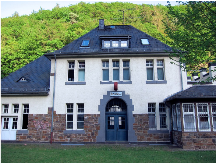
Bahnhofsgebäude in Ahrbrück (2015) Fotograf/Urheber: Elmar Knieps
