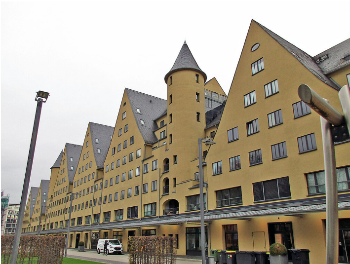
Das Danziger Lagerhaus "Siebengebirge" am Rheinauhafen in Köln-Altstadt-Süd von der vom Rhein abgewandten Seite aus gesehen (2021). Fotograf/Urheber: Franz-Josef Knöchel
