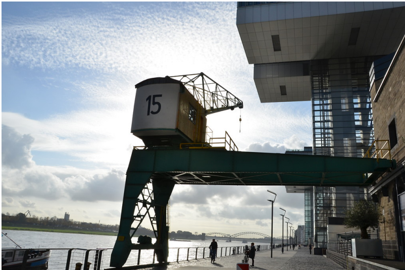
Hafenkran Nr. 15 im Kölner Rheinauhafen (2013) Fotograf/Urheber: Leblebici, Suzan
