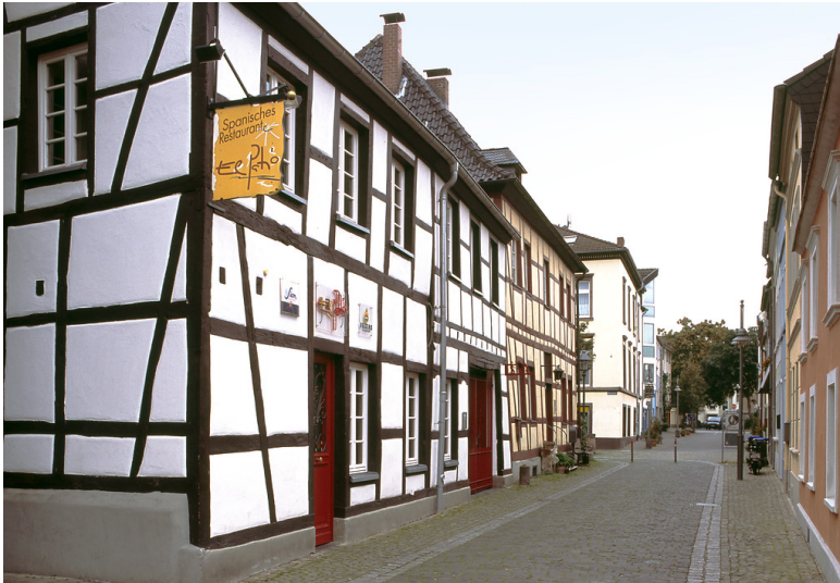
Brühl, Denkmalbereich Nordwestliche Altstadt Fotograf/Urheber: Jürgen Gregori
