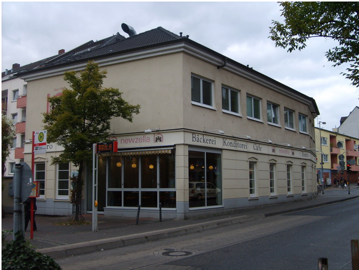
Eckgebäude Kuthstraße und Ostheimer Straße in Köln-Vingst (2013) Fotograf/Urheber: Kleefeld, Klaus-Dieter
