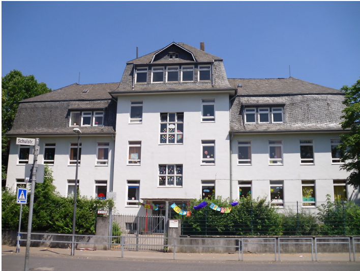
Ehemaliges Pflegehaus, später Schule in der Schulstraße in Köln-Vingst (2013) Fotograf/Urheber: Klaus-Dieter Kleefeld
