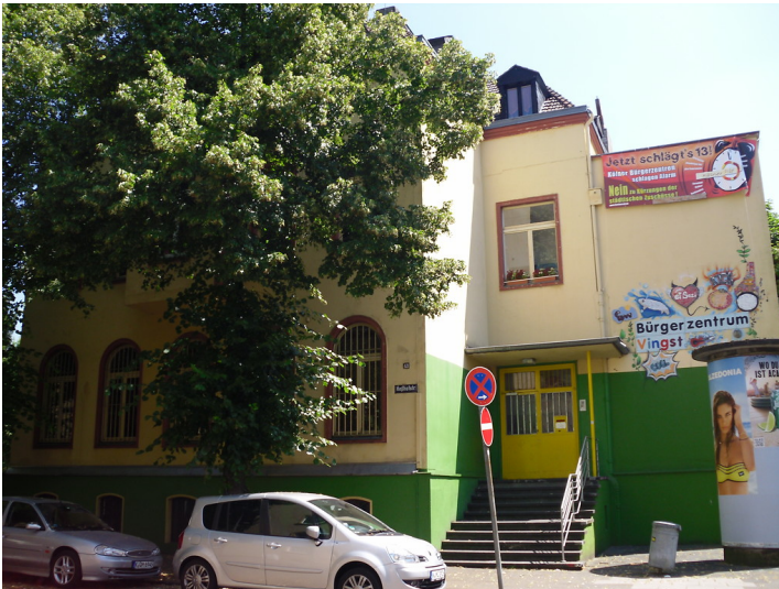
Ehemaliges Rathaus in Köln-Vingst an der Heihofstrae (2013) Fotograf/Urheber: Klaus-Dieter Kleefeld
