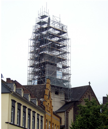
Gerüst am Turmhelm der Pfarrkirche St. Pankratius Kaisersesch (26.07.2013). Fotograf/Urheber: Knöchel, Franz-Josef
