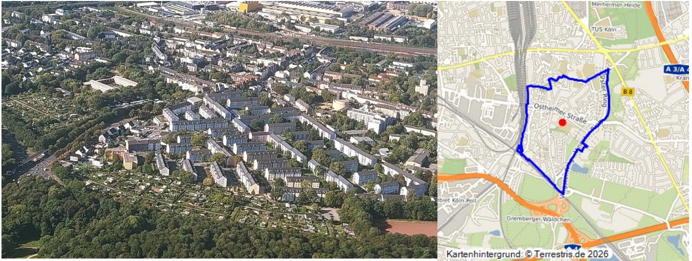
Luftaufnahme von Köln-Vingst in westliche Richtung (2021), zentral im Bild die Straßenzüge der Lustheider Straße, Thorwaldsenstraße und Nobelstraße. Fotograf/Urheber: Franz-Josef Knöchel
