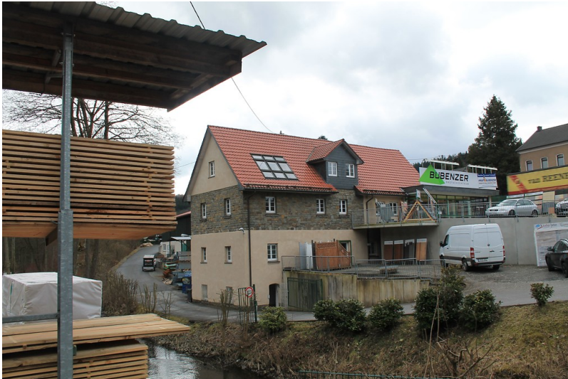
Das Gebäude der alten Sägemühle Mühlenau in Oberwiehl (2012). Fotograf/Urheber: Walgern, Philipp
