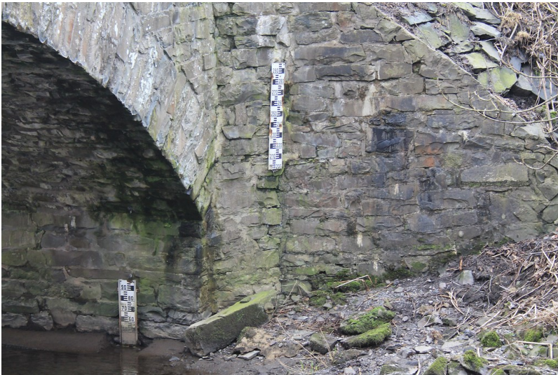
Eine Brücke aus Bruchstein in der Nähe der ehemaligen Sägemühle Mühlenau (2012). Zu erkennen ist der Pegelmesser. Fotograf/Urheber: Walgern, Philipp
