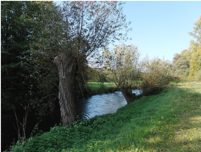
Kopfbaumreihe am Mühlenteich bei Selhausen (2011) Fotograf/Urheber: Ohlhoff, Dagmar
