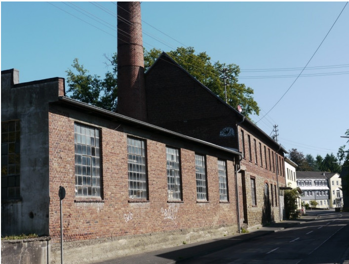
Krautpatsche, früheres Fabrikgelände in Waldbröl (2013) Fotograf/Urheber: Wolfgang Schäfer
