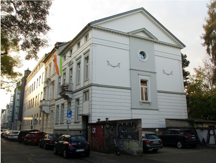
Blick aus nördlicher Richtung auf die Villa Prinz-Albert-Straße 36 in der Bonner Südstadt (2020). Fotograf/Urheber: Franz-Josef Knöchel
