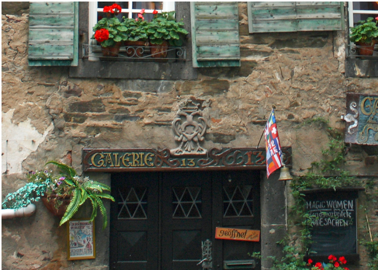
Ein in Stein gehauener kaiserlicher Doppeladler mit Davidstern über dem Hauseingang der ehemaligen Beilsteiner Synagoge (2012). Fotograf/Urheber: Reinhard Hauke
