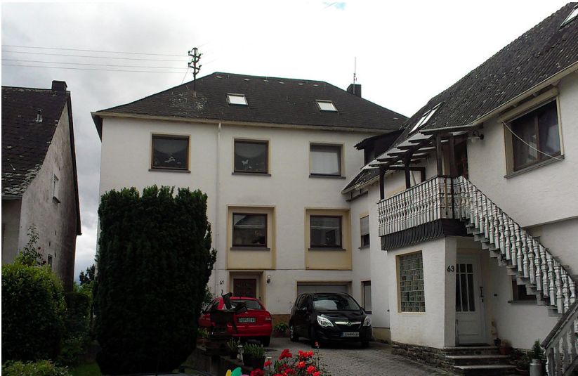
Wohnhaus in der Binninger Hauptstraße, in dem sich vor der NS-Zeit die Synagoge befunden hatte (2013) Fotograf/Urheber: Knöchel, Franz-Josef
