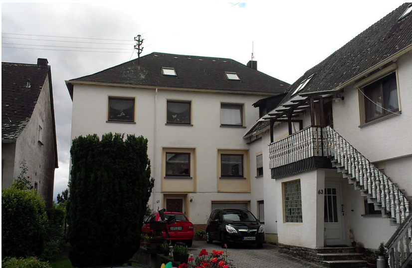
Wohnhaus in der Binninger Hauptstraße, in dem sich vor der NS-Zeit die Synagoge befunden hatte (2013) Fotograf/Urheber: Knöchel, Franz-Josef
