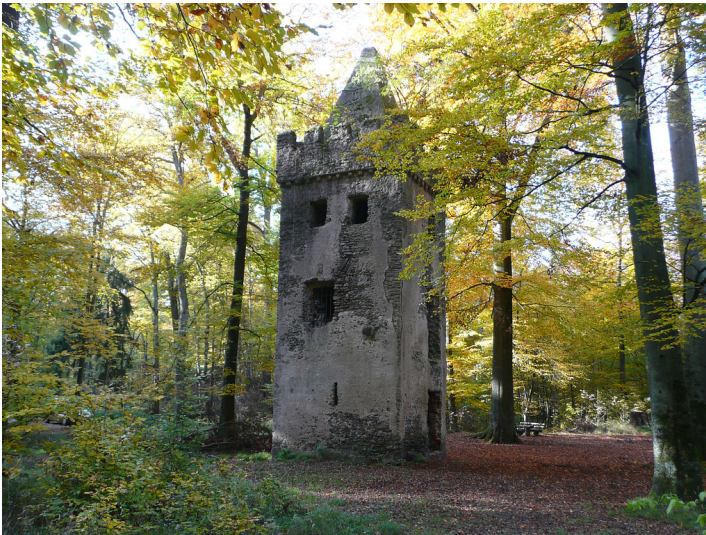
Frei stehender Kirchenturm der Ruine des Klosters St. Wolfgang von Osten (2012) Fotograf/Urheber: Schwitalla, Guntram
