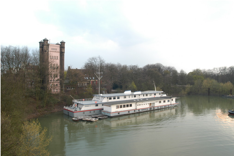
Trajektturm mit ehemaligem Eisenbahnhafen und Schulschiff Rhein in Duisburg-Homberg (2006) Fotograf/Urheber: Gelhar, Martina
