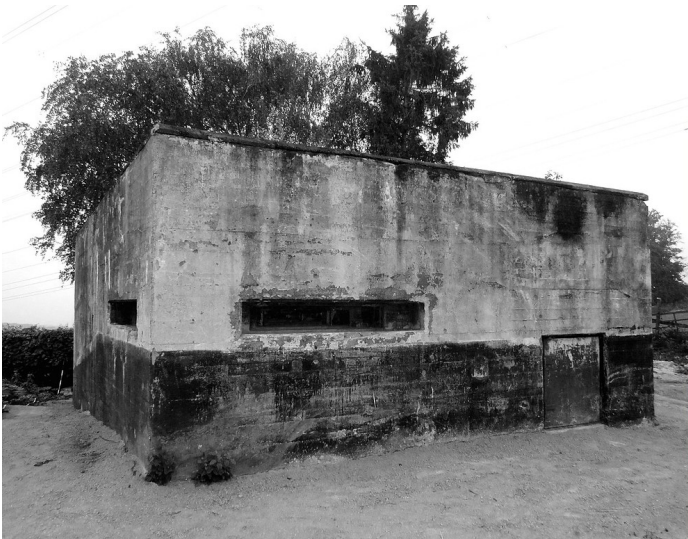
Ansicht des Leitbunkers der Krupp'schen Nachtscheinanlage (2013).
