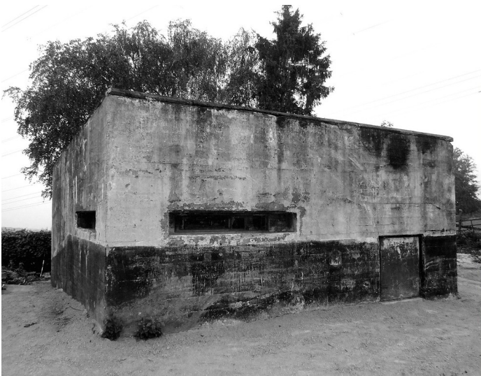
Ansicht des Leitbunkers der Krupp'schen Nachtscheinanlage (2013).
