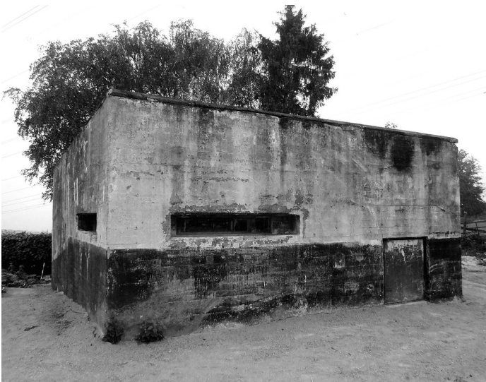
Ansicht des Leitbunkers der Krupp'schen Nachtscheinanlage (2013).
