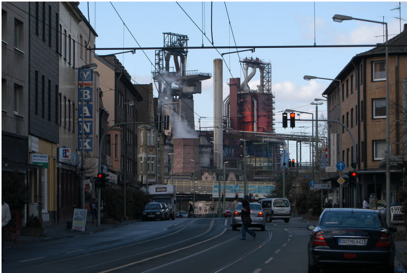
Industrielle Gemengelage im Duisburger Stadtteil Bruckhausen (2009) Fotograf/Urheber: Gelhar, Martina
