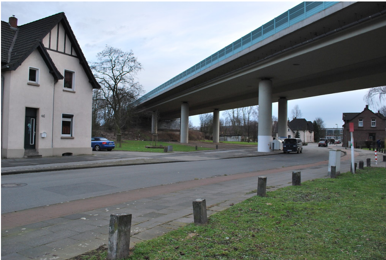
Alte Zinkhüttensiedlung in Duisburg-Marxloh (2013) Fotograf/Urheber: Martina Gelhar
