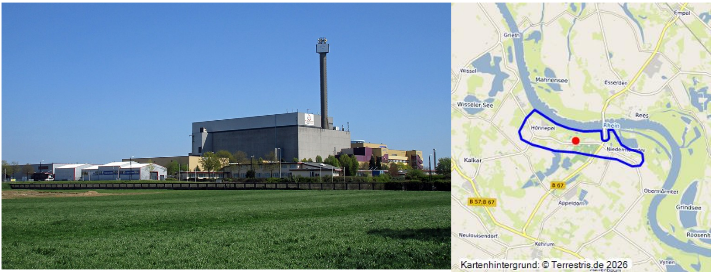
Ansicht der Gesamtanlage des früheren Kernkraftwerks Schneller Brüter bei Kalkar-Hönnepel aus nordwestlicher Richtung (2016). Fotograf/Urheber: Felicitas Gildenhard
