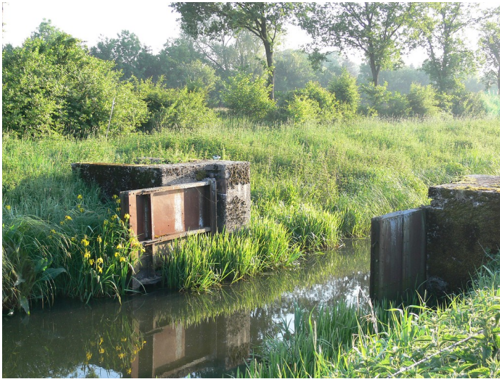
Historisches Wehr Fotograf/Urheber: Cerff, Dietrich
