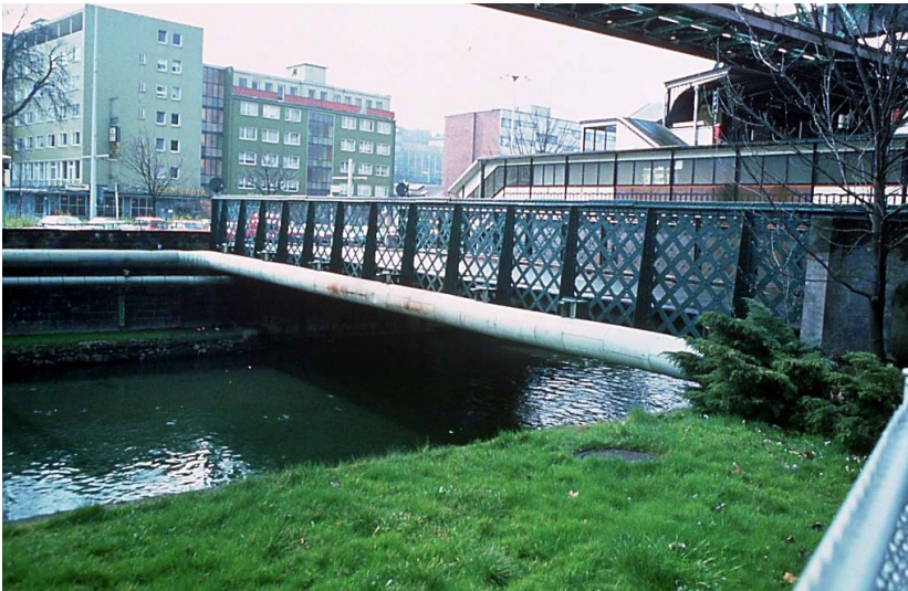
Die Adlerbrücke über die Wupper (1994). Fotograf/Urheber: Buschmann, Walter
