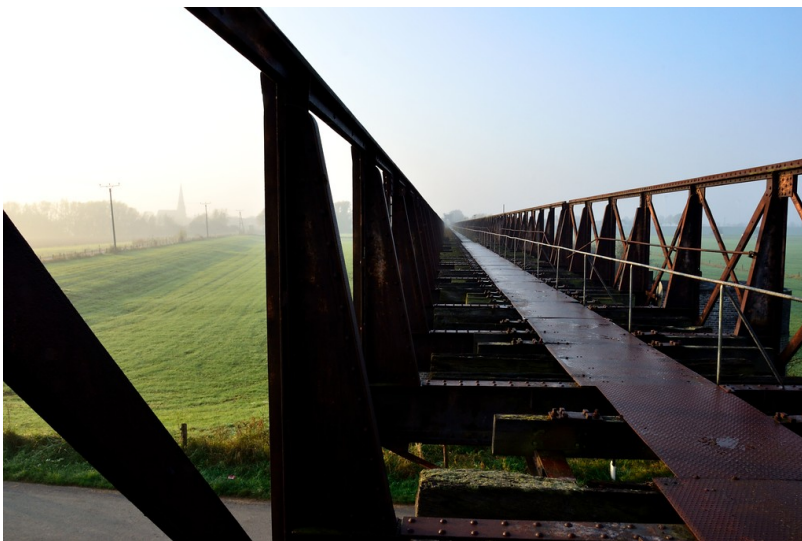
Eisenbahnbrücke Griethausen (2011) Fotograf/Urheber: Ulrich Werneke
