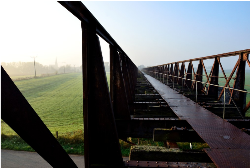
Eisenbahnbrücke Griethausen (2011) Fotograf/Urheber: Ulrich Werneke
