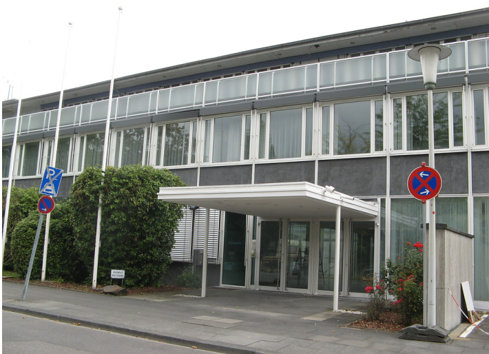
Die Eingangsseite der ehemaligen Landesvertretung Bayern von der Bonner Schlegelstraße aus gesehen (2008) Fotograf/Urheber: Angelika Schyma
