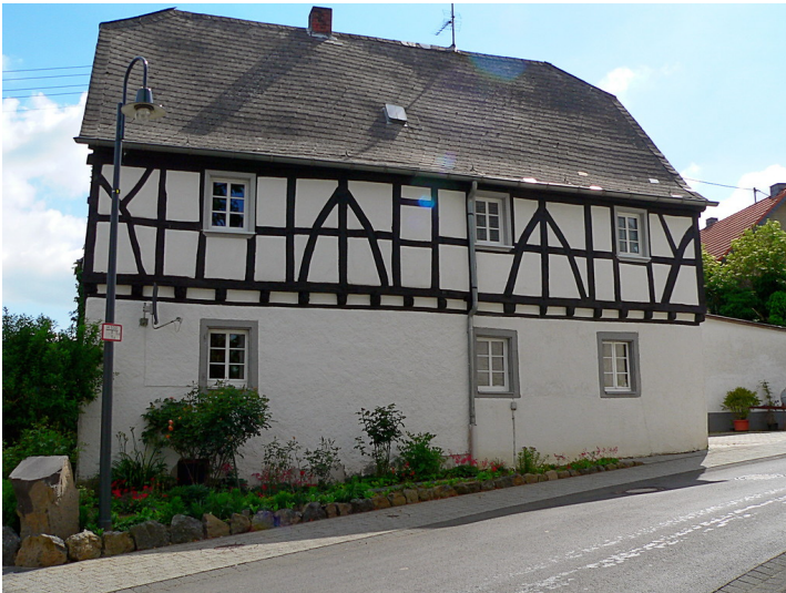
Seitenansicht des Bockfachwerkhauses in Borler bei Kelberg (2008). Fotograf/Urheber: Peter Burggraaff
