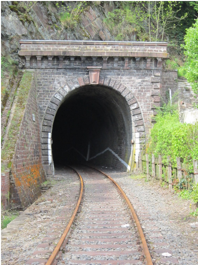
Tunnelportal Gemünder Tunnel (2012) Fotograf/Urheber: Weber, Claus
