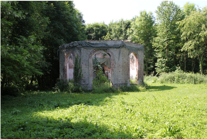
Ruinöser Pavillon (Badehaus) im Schlosspark Diersfordt (2012) Fotograf/Urheber: Burggraaff, Peter
