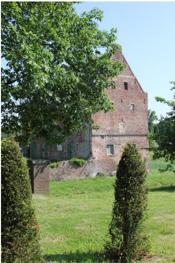
Porthaus von Schloss Diersfordt (2012) Fotograf/Urheber: Burggraaff, Peter
