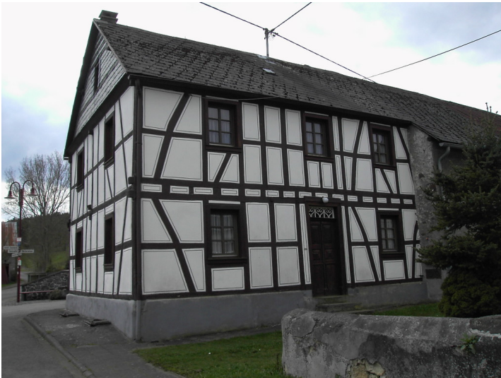
Fachwerkgebäude der Alten Post in Kelberg-Rothenbach (2008) Fotograf/Urheber: Burggraaff, Peter
