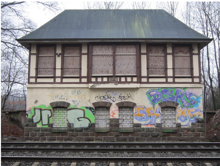
Bahnseitige Front des Stellwerkes No im Bahnhof Neanderthal (2013). Im Vordergrund die Gleise der Bahnstrecke von Mettmann nach Gerresheim Fotograf/Urheber: Weber, Claus
