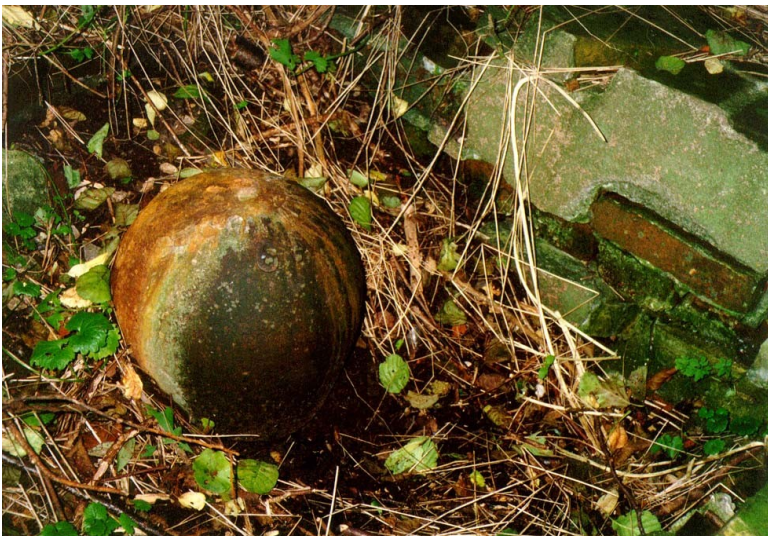
Druckbehälter des hydraulischen Widders in Klein Wittensee (2013) Fotograf/Urheber: Telse Stoy
