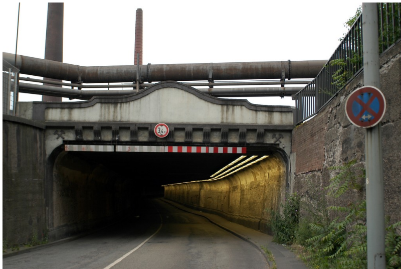
Tunnel Matenastraße, Duisburg-Bruckhausen (2005) Fotograf/Urheber: Gelhar, Martina
